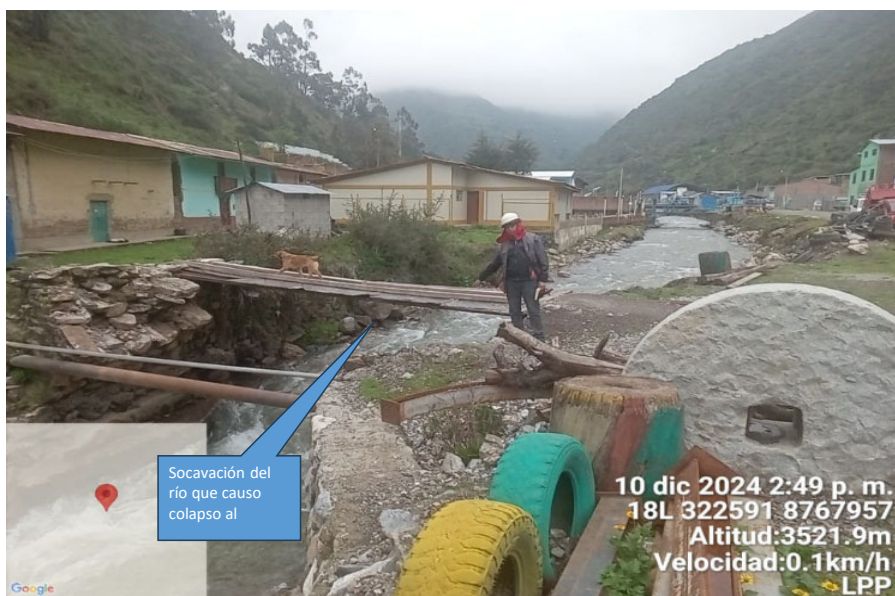
FIGURA N°03: EN LA TEMPORADA DE MAXIMAS AVENIDAS, EL RIO VIVHAYCOCHA CAUSO DAÑOS AL PUENTE DE PIEDRA.
